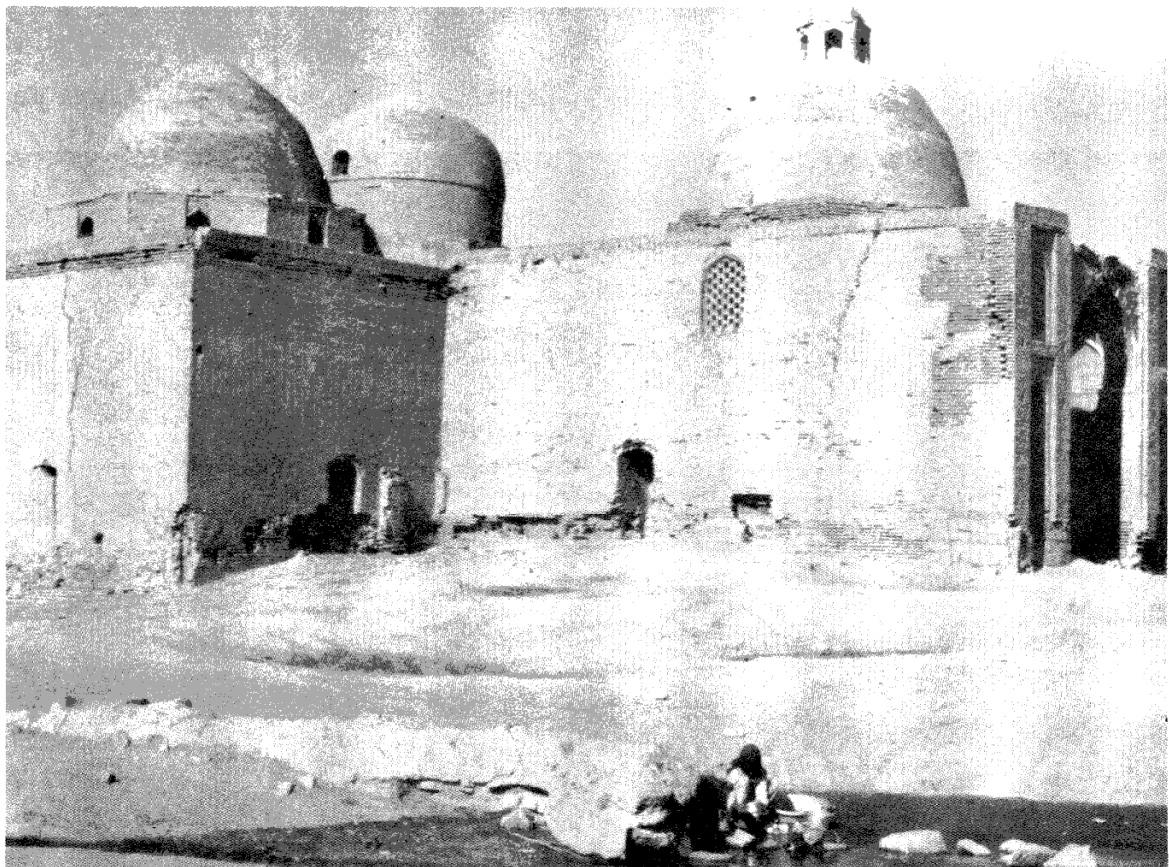
تصویر ۵ پلنگ آباد.
