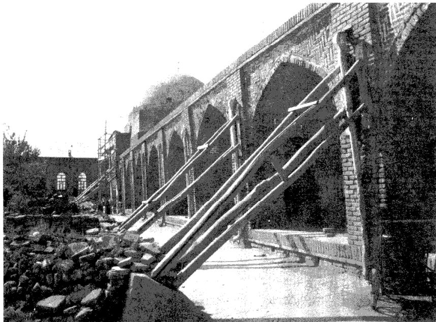
تصویر ۳ ارومیه - مسجد جامع، شمع‌بندی و عملیات رفع خطر.
