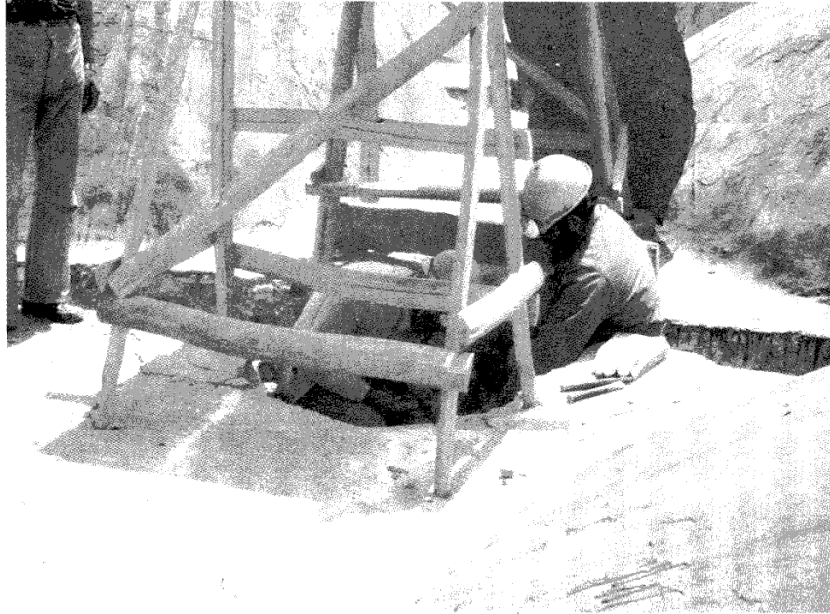
تصویر ۳ ارومیه - مسجد جامع، آهن‌کشی، پایه‌های کمکی عمودی در روی بام بر روی پایه‌های اصلی بنا.
