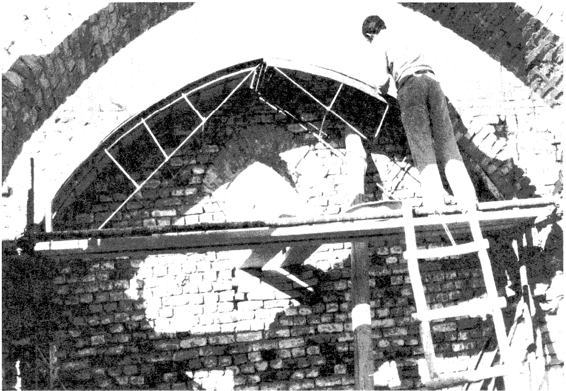
تصویر ۱ اشتهارد - امامزاده، اجرای قوس رومی با استفاده از قالب دید.
