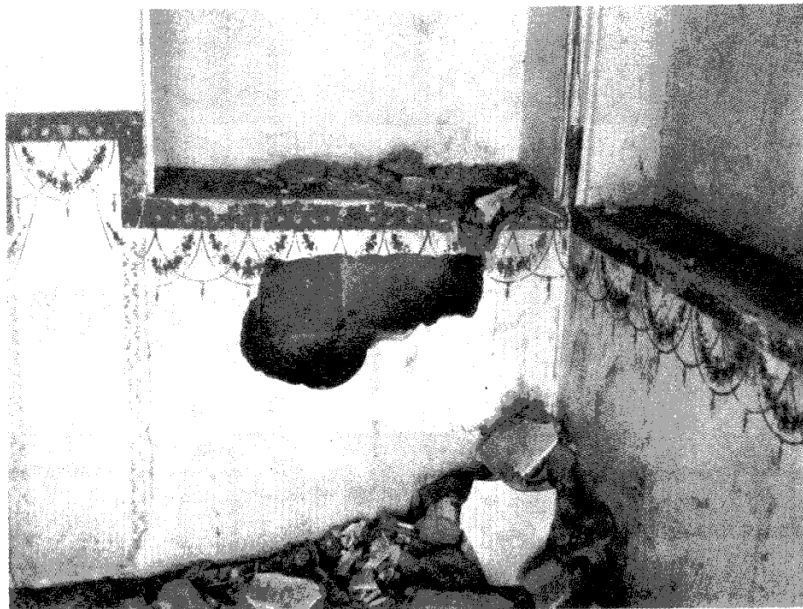
تصویر ۵ کاشان - خانه مسکونی عباسی، صندوقه برای تسهیل عمل دفع رطوبت.
