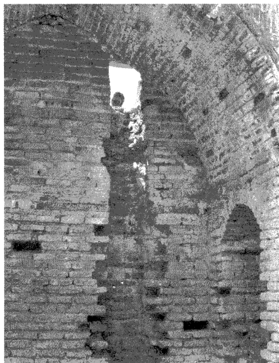
تصویر ۱ ارومیه - مسجد جامع، آهن‌کشی، جاسازی در دیوار بر پایه عمده دی.
