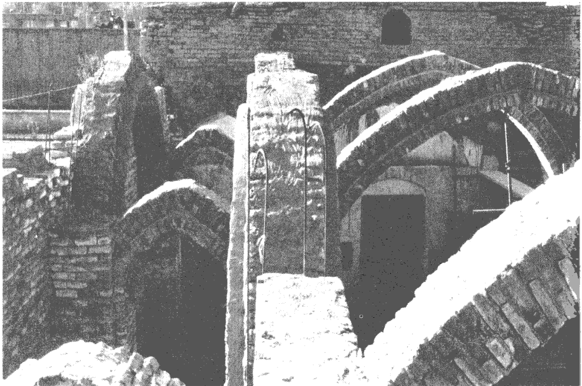
تصویر ۲ اشتهارد - امامزاده، بازسازی و اجرای قوس رومی و تقویت سازه با استفاده از کلاف بتونی در مغز کار.
