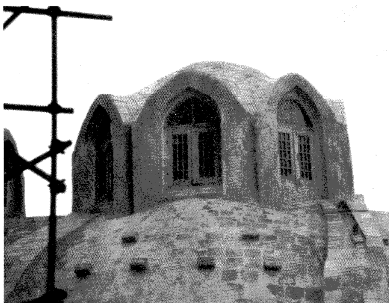
تصویر ۱۵ ماهان - مقبره شاه نعمت‌الله ولی، یکی از نورگیرهای پوشش سقف. نحوه اتصال میل مهارها به کمک کلاف آهنی و بیج و مهره.
