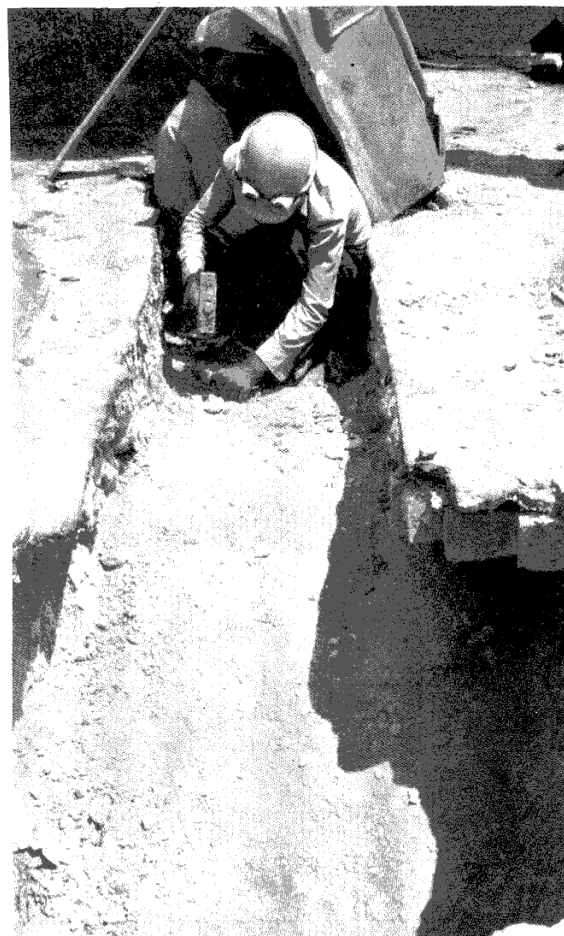
تصویر ۴ ارومیه - مسجد جامع، آهن‌کشی، پایه‌های کمکی عمودی در روی بام بر روی پایه‌های اصلی بنا.
