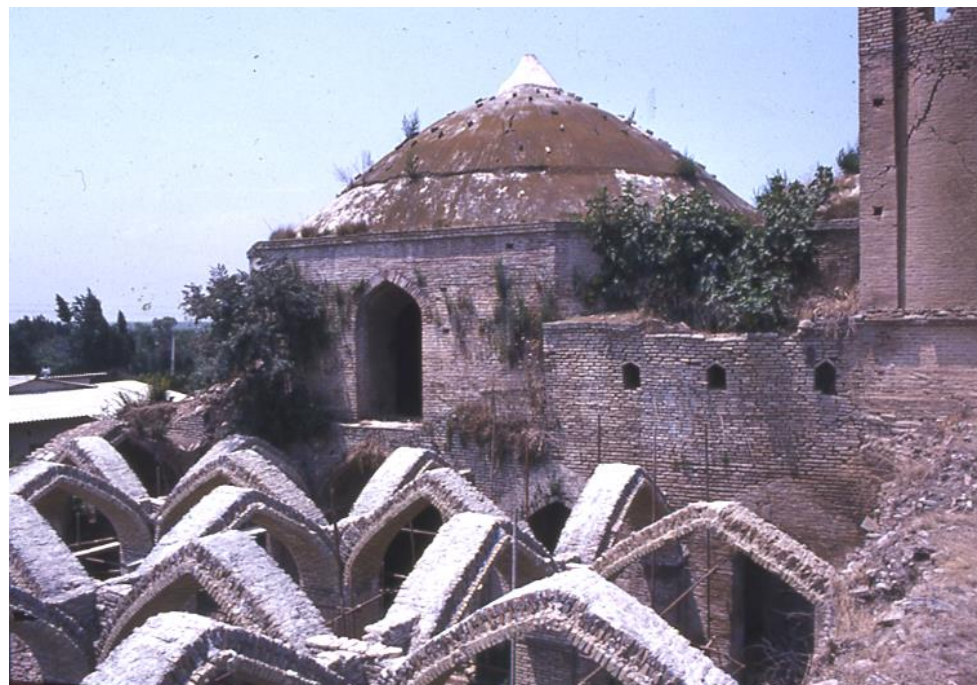
تصویر ۶ مجموعه فرح آباد ساری، پس از یافتن خطوط اصلی بنا برای حفظ الگوی پوششی آن، بر اساس خطوط موجود و به همان شیوه اقدام به بازسازی شده است.
